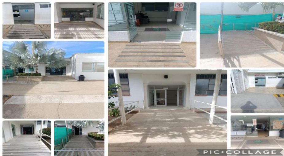
Fotografía 1: Ramplas de Acceso diferentes áreas E.S.E. Hospital del Rosario para Ingreso y Evacuación inclusiva
